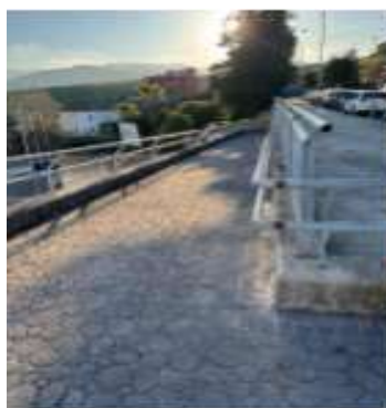
12. Rampa Adaptada. Urb "Mirador de la Bahía". Cd: 11203
