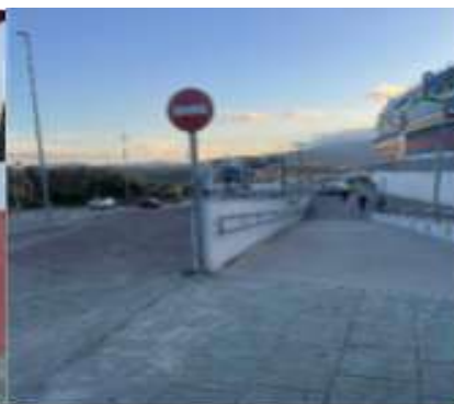
14. Rampa adaptada en el Centro Comercial para personas con movilidad reducida. Avenida Virgen de la Palma. Cd: 11203
