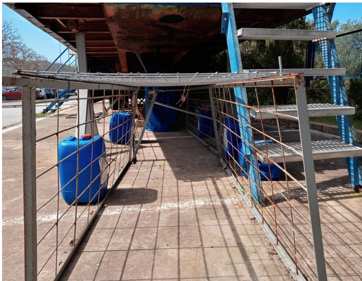
Figura 1: Detalle de entrada al tunel
