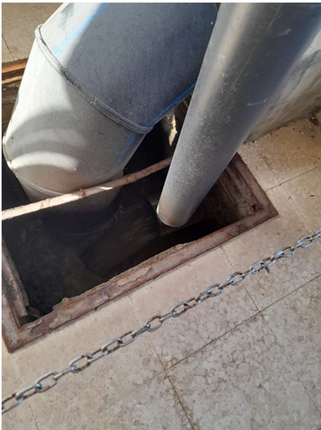
Detalle agua residual a la entrada de la Planta
