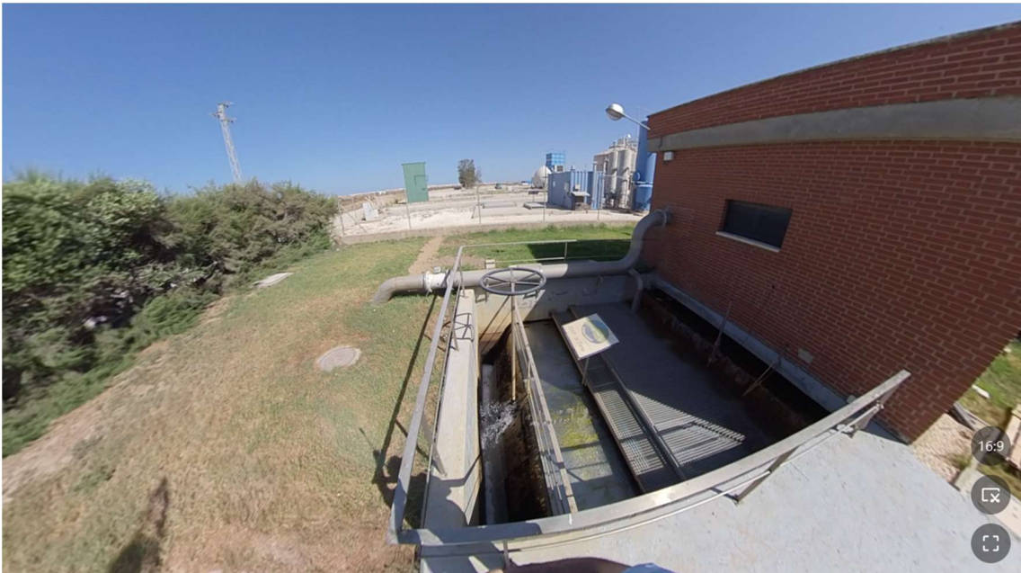
Agua depurada a la salida de la Planta
