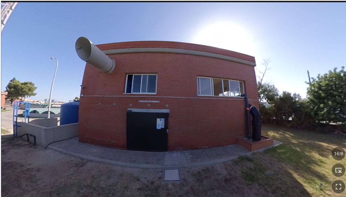
Entrada agua residual (derecha) y sala de pretratamiento
