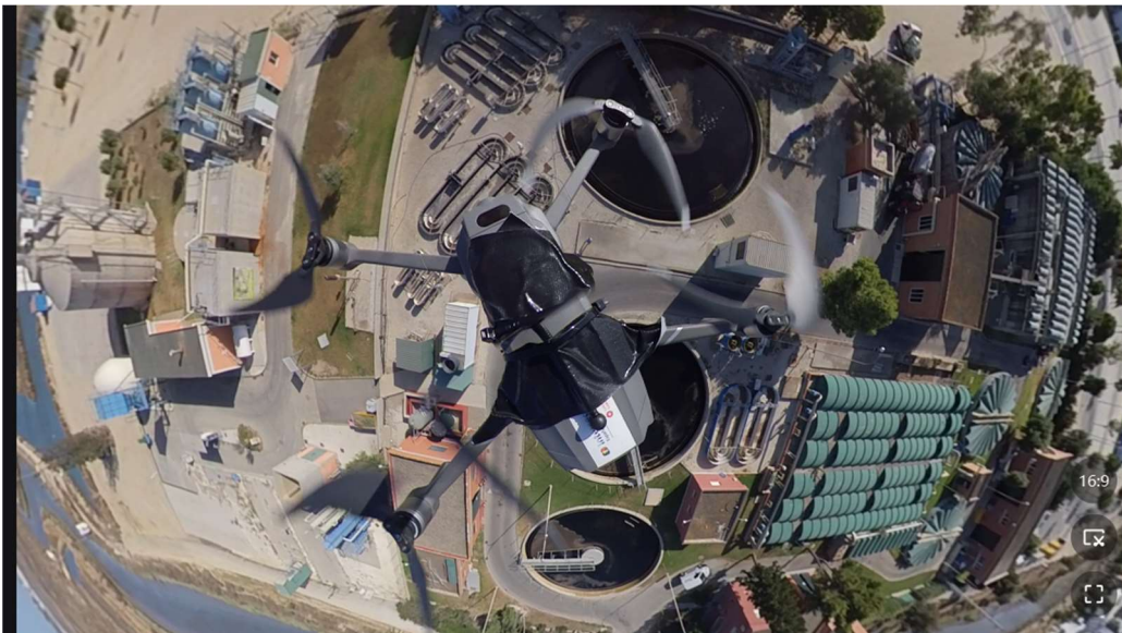
Panorámica general Planta Depuradora
