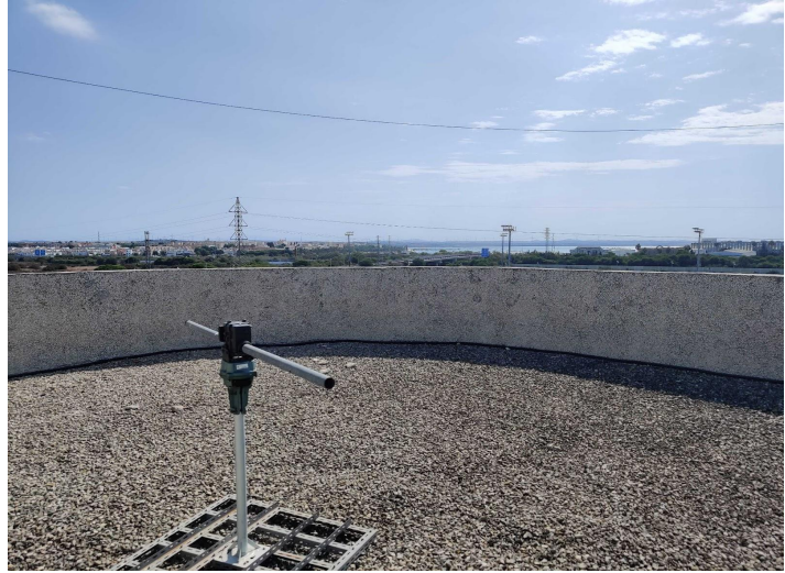
Figura 1.4: Estación de tierra del CASEM en construcción.
