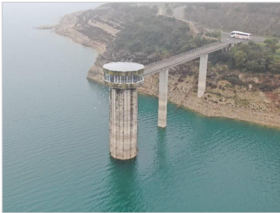
Fotografía 42. Torre de captación del embalse de Guadalquivir.
