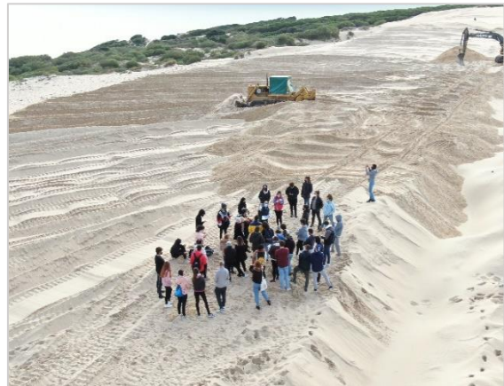
Fotografía 35. Trabajos para detener el avance de la duna de Valdevaqueros sobre la carretera y terrenos colindantes.
