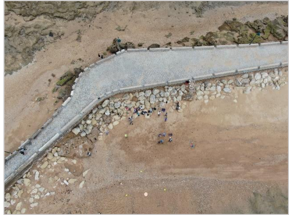
Fotografía 55. Vistas aéreas de la zona de estudio en torno al Castillo de San Sebastián.
