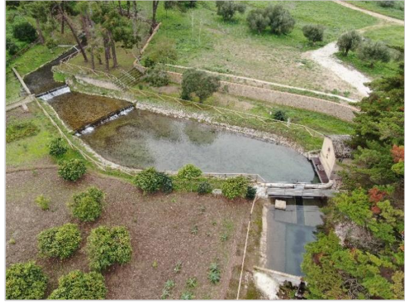
Fotografía 47. Vista aérea del nacimiento del manantial de Tempul.
