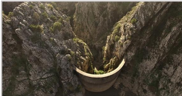
Fotografía 1. Muro de la presa de Montejaque.
